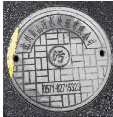
图 9-7 钢纤维混凝土井盖
