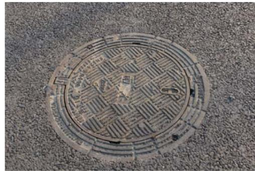
图 9-8 球墨铸铁防沉降井盖
